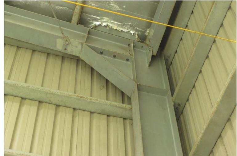
柱頂接頭，強軸 $\alpha_t=1.0$ ，弱軸 $\alpha_t=0$
